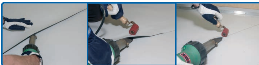
Рисунок 2. Формирование ручного сварного шва в три этапа
