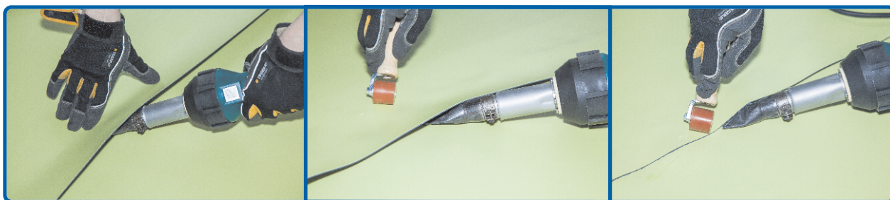
Рисунок 14.2. Ручная сварка методом в «три этапа».
